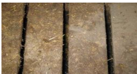
Figur 6. 1.: Ingen tilkitning. Ingen tilkitning af spalteåbning. Spalteåbningerne er frie for tilkitning og der er fri passage for gennemgang af gødning.
