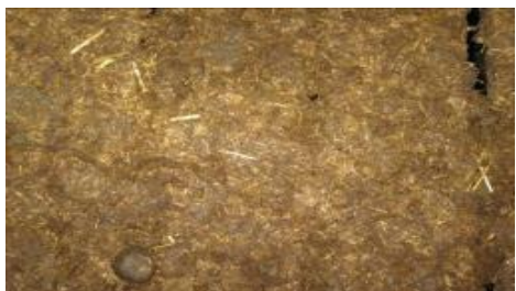
Figur 6. 3.: Fuldstændig tilkitning. Fuldstændig tilkitning af spalteåbning. Spalteåbningen er helt tilkittet og der er ikke mulighed for gødningsgennemgang.
